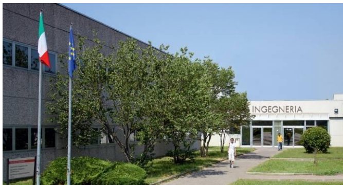
Ingresso della Sede Scientifica di Ingegneria
